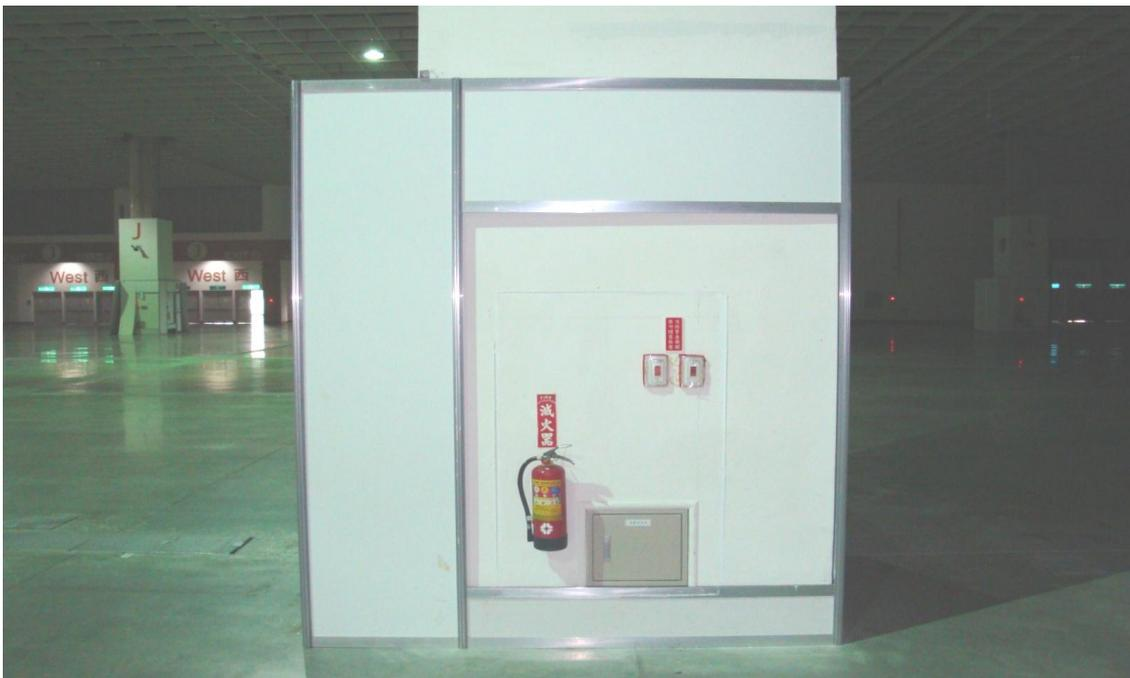
展場內奇數列柱子東側須預留高140公分、寬110公分之牆洞以外露設備。外露設備含(1)報警盤，(2)消防灑水系統開關2只，(3)滅火器1只，(4)接地盤1座。
