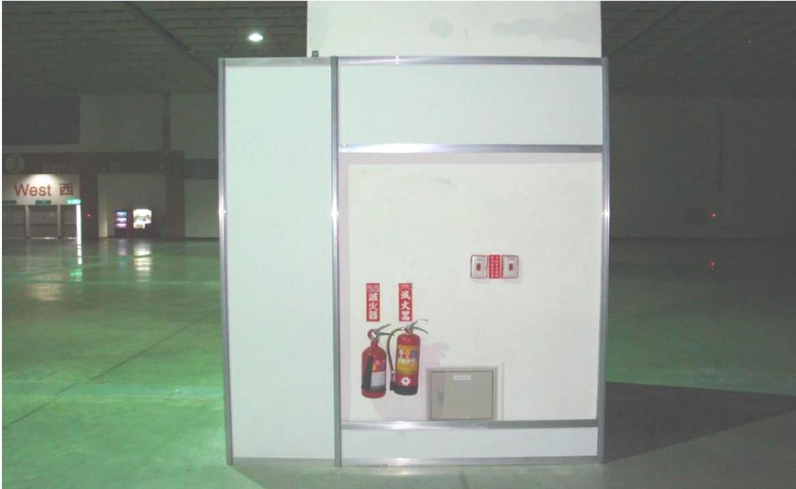
展場內偶數列柱子東側須預留高140公分、寬110公分之牆洞以外露設備。設備含(1)消防灑水系統開關2只，(2)滅火器2只，(3)接地盤1座。
